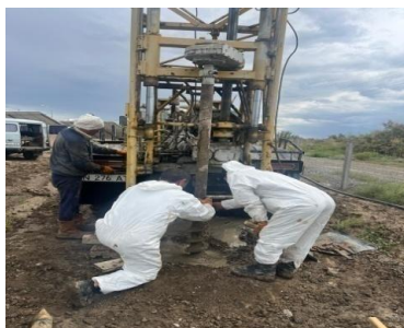
7-сурет – Бақылау ұңғымасын орналастыру
