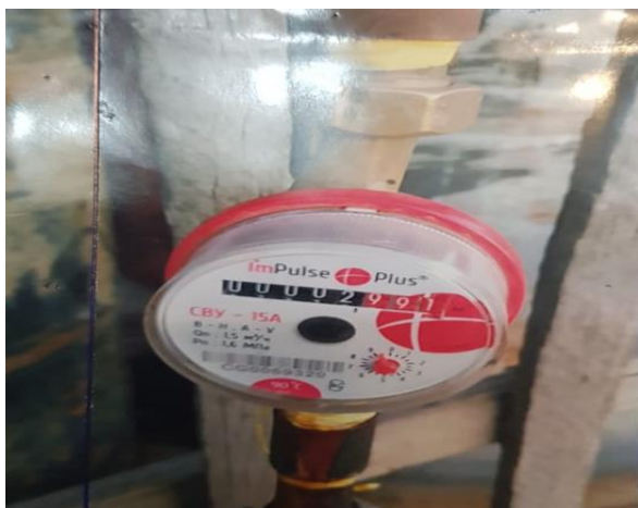
2-Сурет - «ImPulse Plus» қалақты су есептеуіш (MP-3 типідегі. №11032183)
