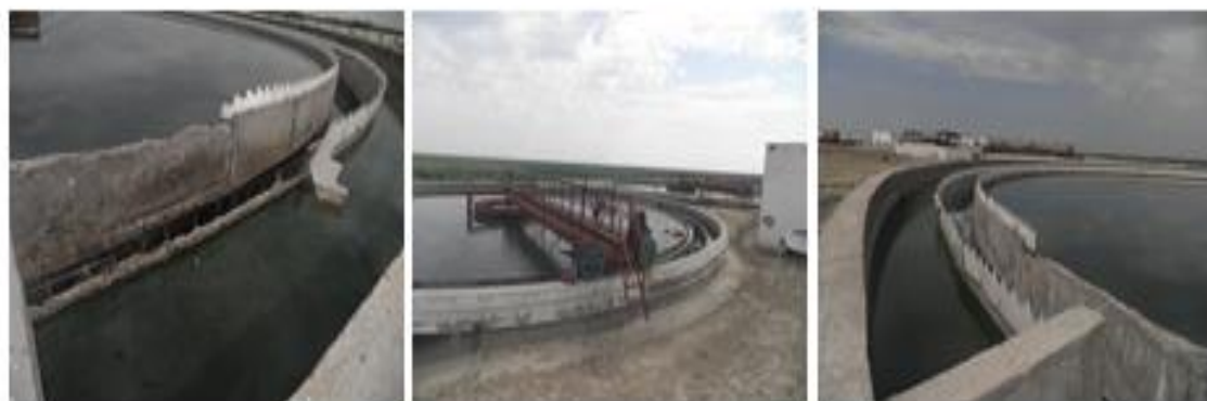
Рисунок 2 – Вторичный радиальный отстойник
